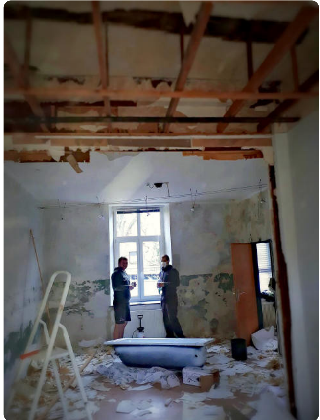
Februar 2020: der spätere Trainingsraum, entkernt bis auf die Balken
